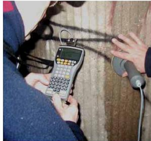
Columna de un puente de avenida siendo probado con el GalvaPulse.
