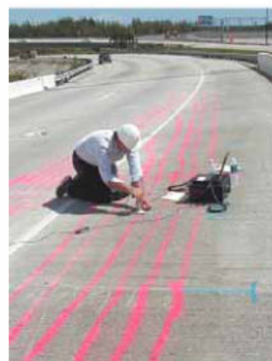
Prueba para conocer la calidad de la inyección de grout en ductos de postensado localizados por
