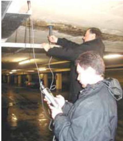
GalvaPulse. Velocidad de Corrosión Medida en una junta con humedad
